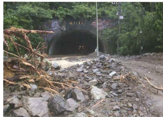
写真-6 土砂災害により通行不能となったトンネル
