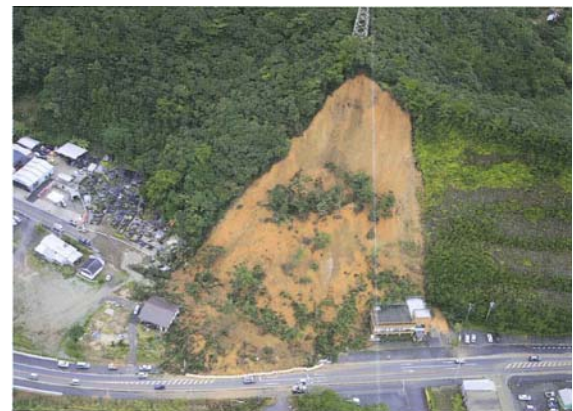
写真-5 地すべりによる被災状況
