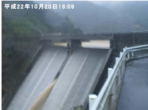
写真-7 非常用洪水吐きからの越流状況
