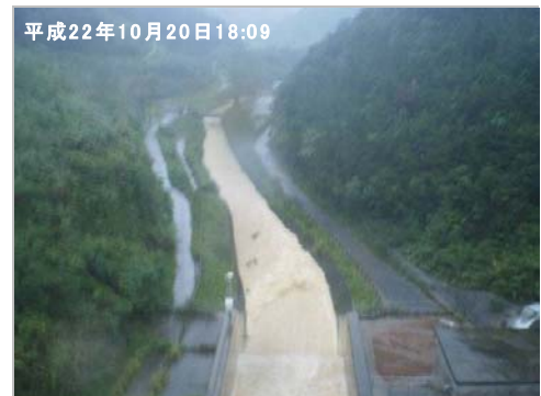
写真-9 ダム直下(三田川)の状況
