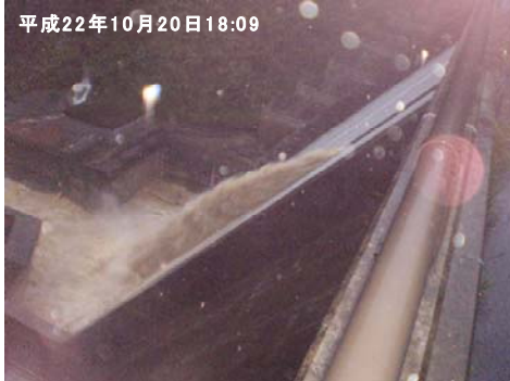
写真-8 常用洪水吐きからの放流状況
