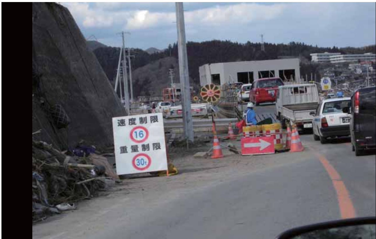
仮設道路橋 (住民等が通行できるよう、道路橋が設けられている。)
