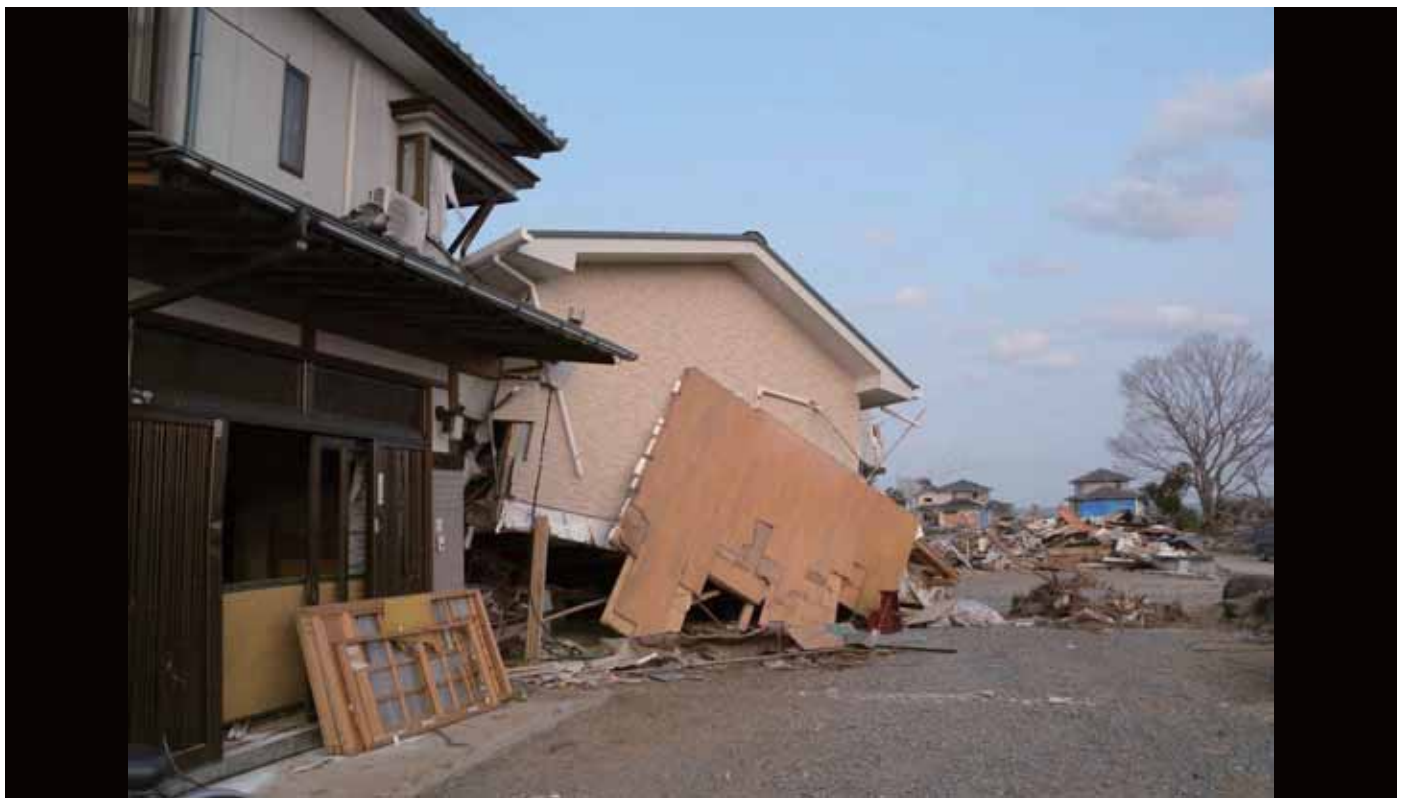
ハジカミ オイセハマ 気仙沼市波路上・御伊勢浜 (50 m程流された住宅の2階部分が他の住宅に衝突した.)
