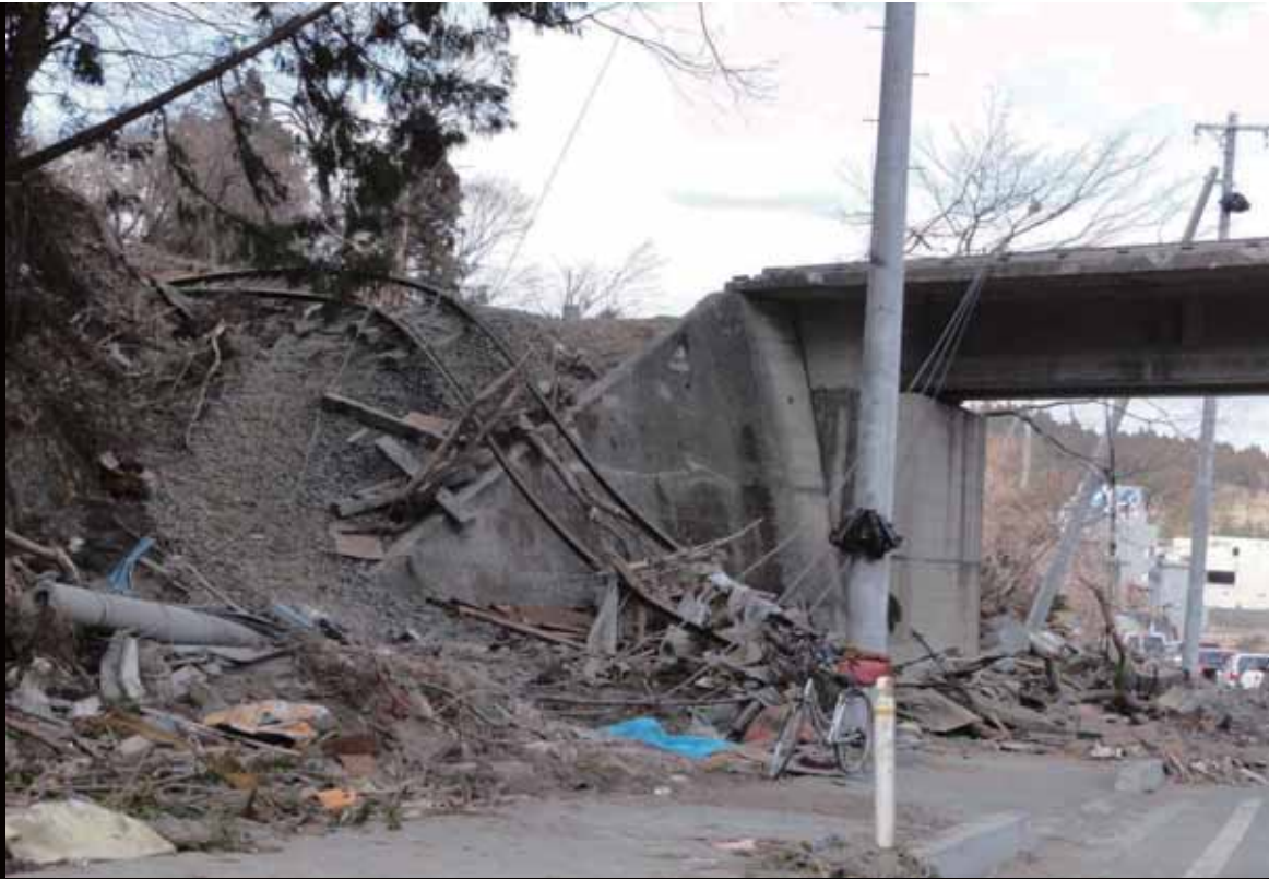
JR気仙沼線の線路 (線路が落下した。)
