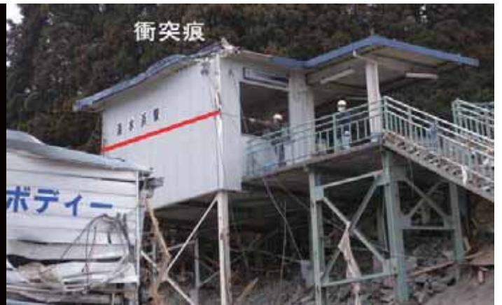
JR清水浜駅の駅舎と津波の痕跡
