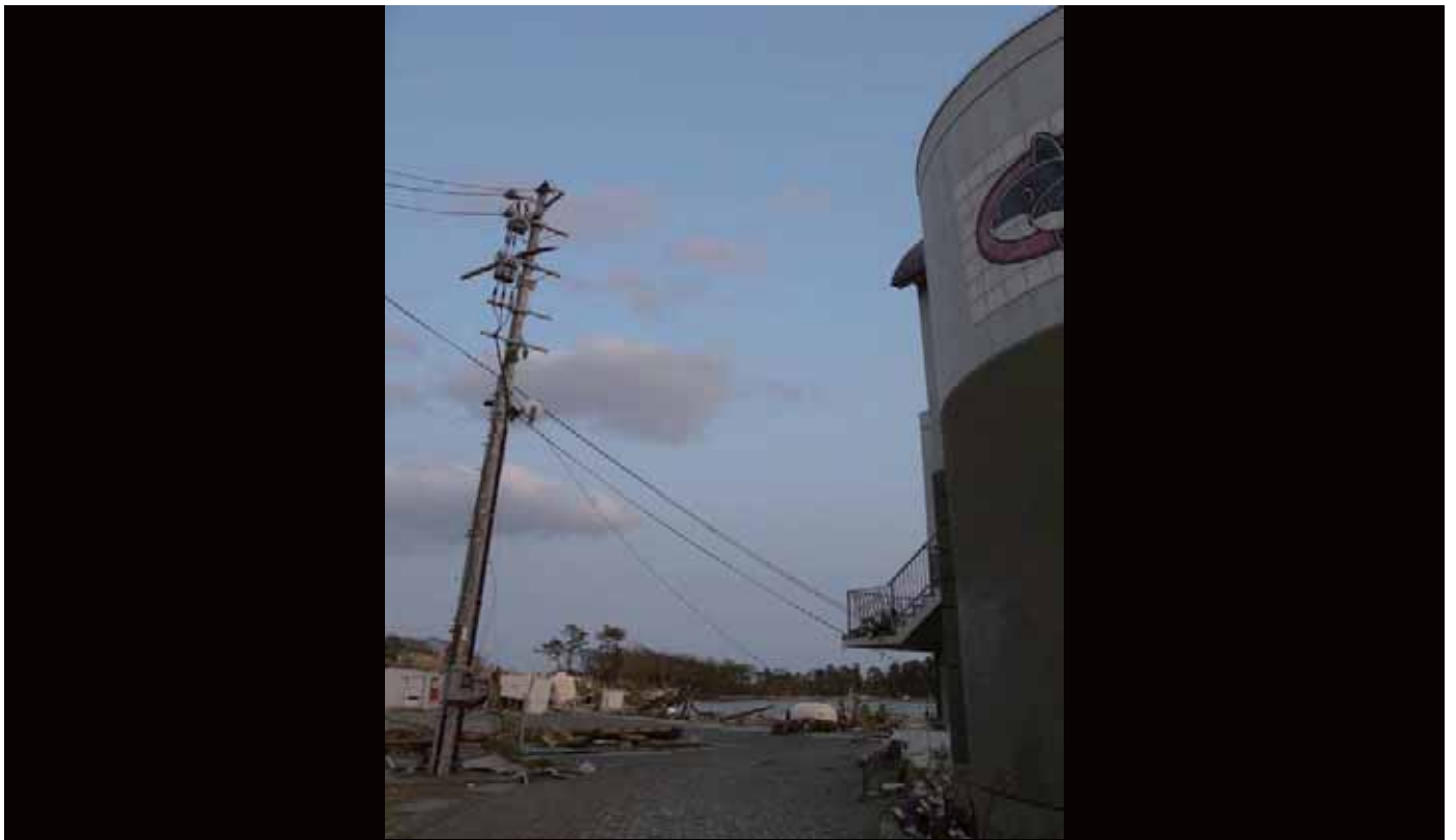
気仙沼市本吉町・大谷海岸 (曲がった電柱の上に、木材が乗っている。)
