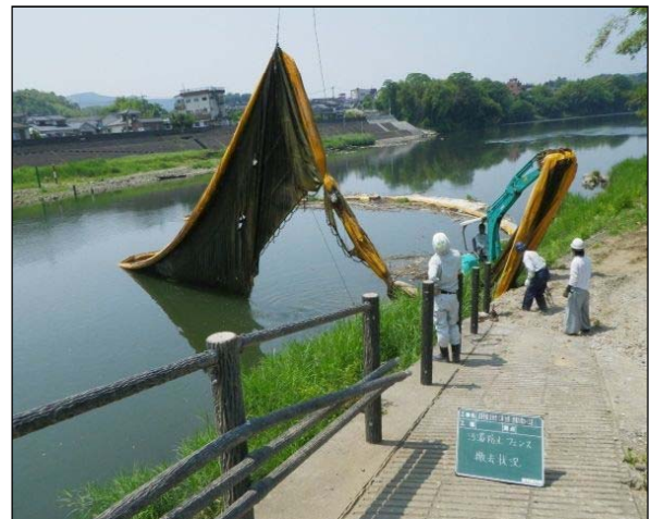
汚濁防止フェンス撤去
