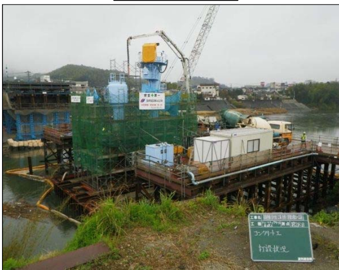
コンクリート打設工
