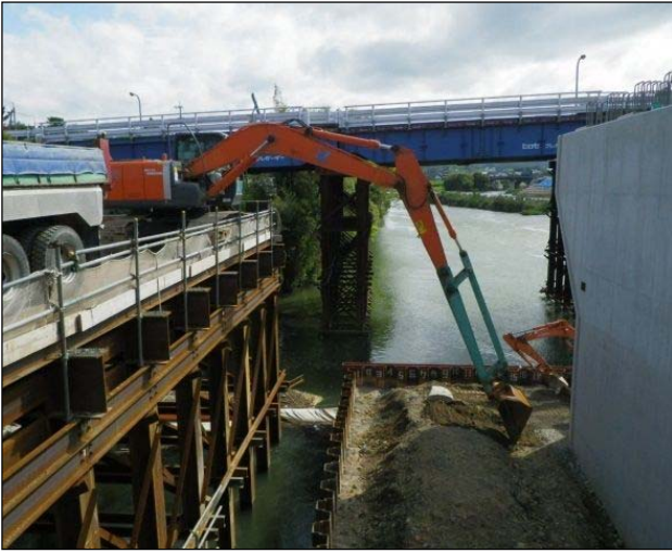
築島盛土撤去
