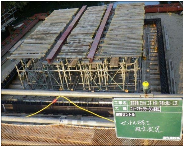
セントル支保工
