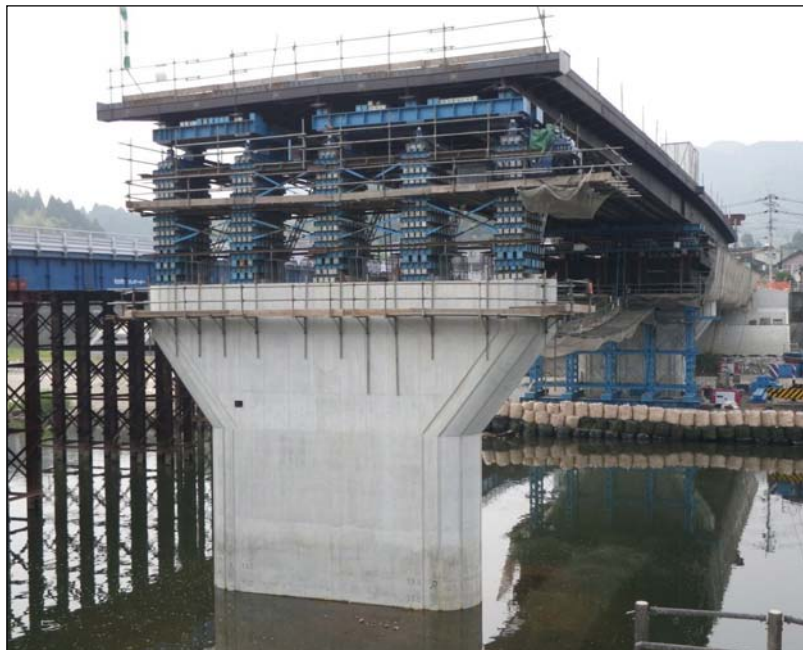
P1橋脚工施工完了
