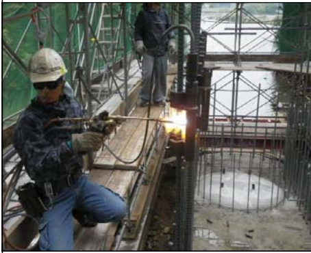
鉄筋ガス圧接
