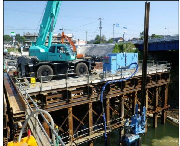
鋼矢板引抜き
