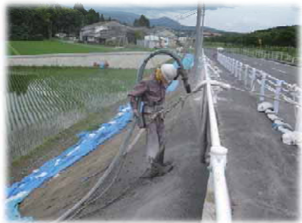
吹付作業状況
