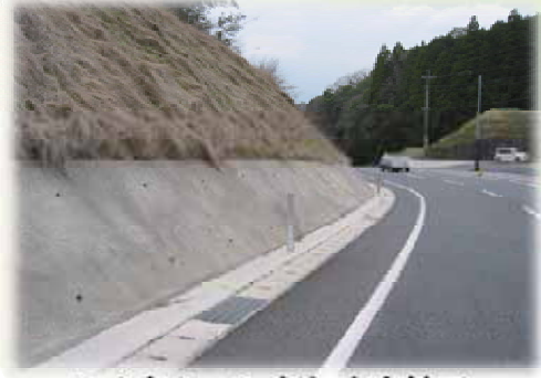
モルタル・コンクリート吹付工
