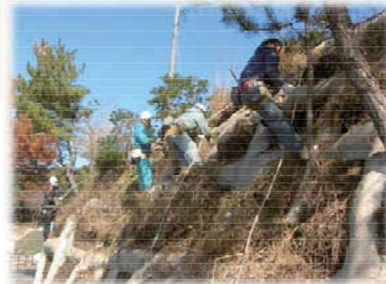
のり面での除草作業
