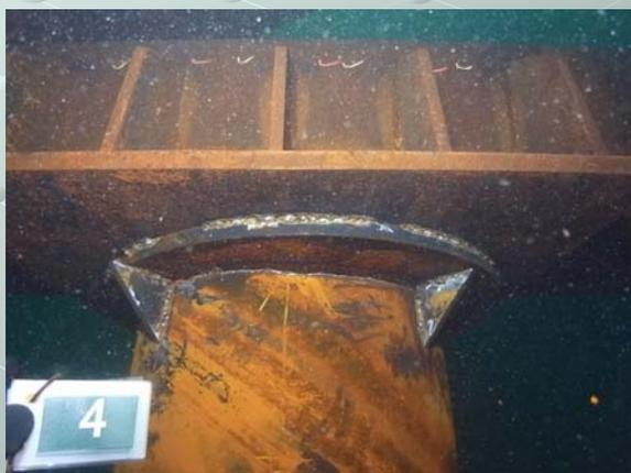
ジャケット本体と仮受杭4本を水深約26mの箇所で溶接し、ジャケット本体を支えます。
