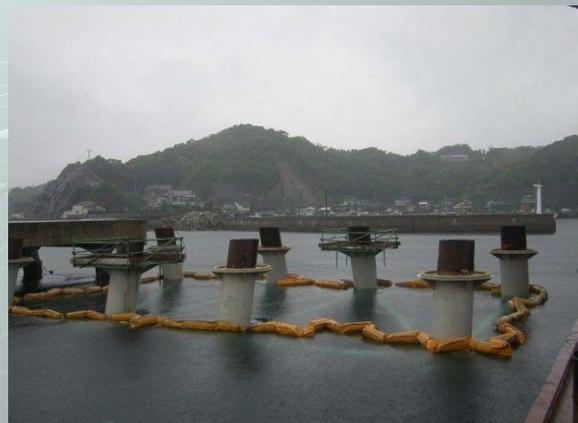
本杭の打設完了後は、ジャケット本体と本杭のすき間に引抜抵抗力を増すためにグラウトを注入し、構造物を一体化させます。
