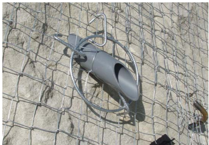
水抜き穴補強筋
