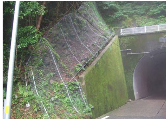
(一) 岸良高山線 二股隧道
