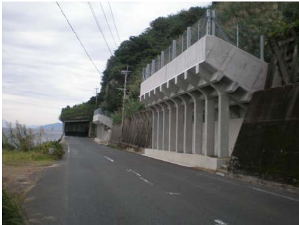
国道269号 南大隅町浮津
