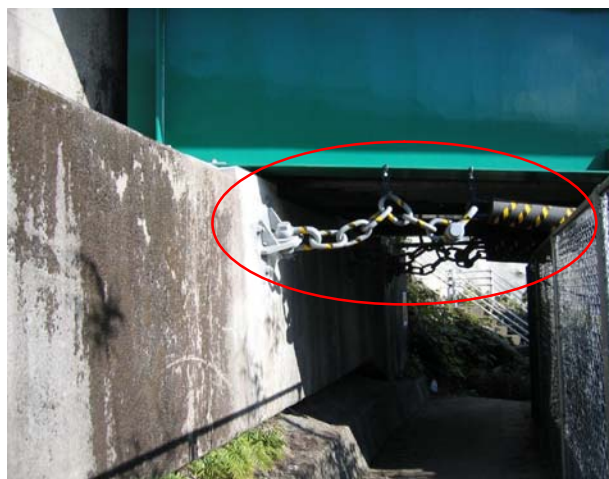
落橋防止構造【緩衝チェーン】
