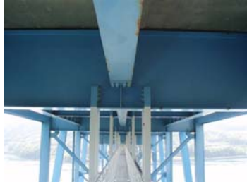
⑤既設部材の腐食状況
