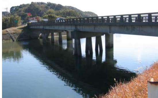
道路補修事業（橋梁耐震補強） 日置市東市来町神之川橋
