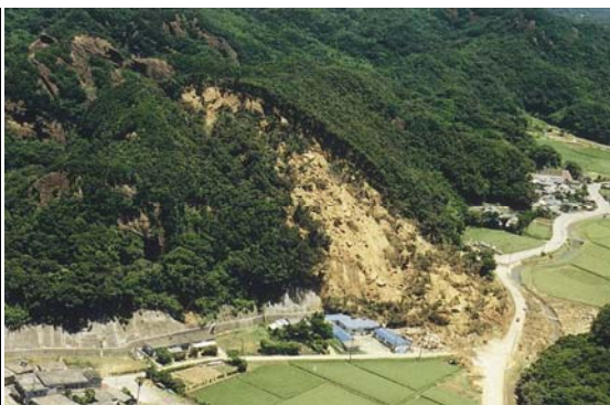
平成7年に荃永地区で発生した地すべり
