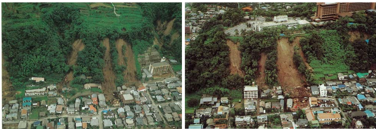
写真左: 武2地区, 写真右: 平之町地区 「シラス崖災害」(鹿児島県土木部砂防課)より
