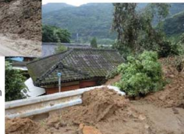
町道の復旧状況 (崩壊斜面に2～5m 程度の転石あり)
