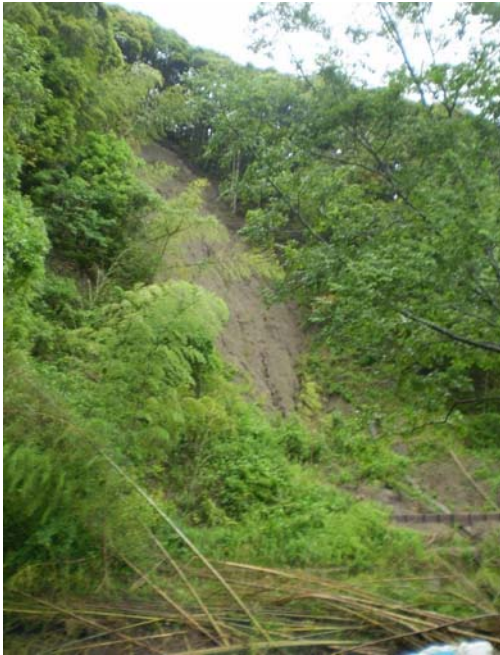
霧島市橋口地区(山地災害危険箇所)
