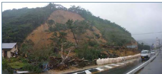
崩土除去と大型土嚢設置により交通解放。
