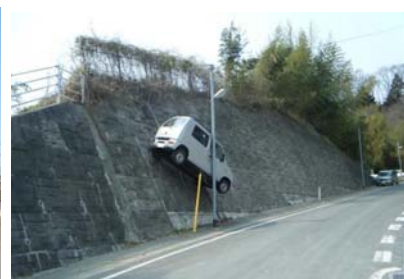
写真-2 津波遡上の痕跡と健全な PAN WALL
