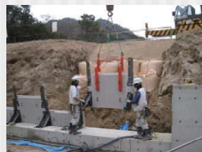
下流外部保護材(コンクリートブロック)
