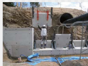
下流外部保護材(コンクリートブロック)
