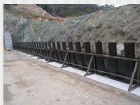
上流外部保護材(軽量鋼矢板)
