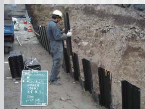
上流外部保護材(軽量鋼矢板)
