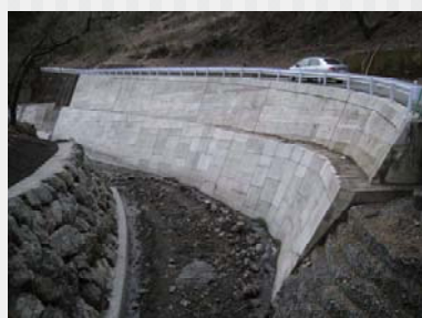
導流工への適用事例 ( INSEM-S、INSEM-B )
