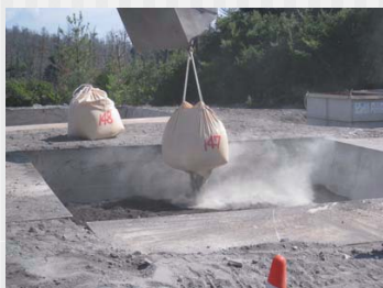
混合(セメント投入)
