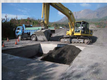
搬出(ダンプトラック)
