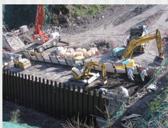
搬入・敷均し
