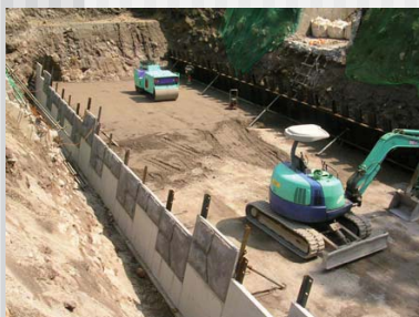
締固め(振動ローラ)
