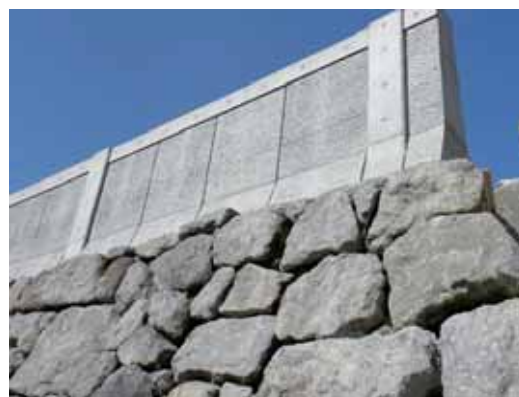
完成写真(胸壁部)
