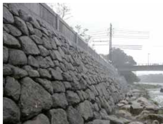
完成写真(石積断面)
