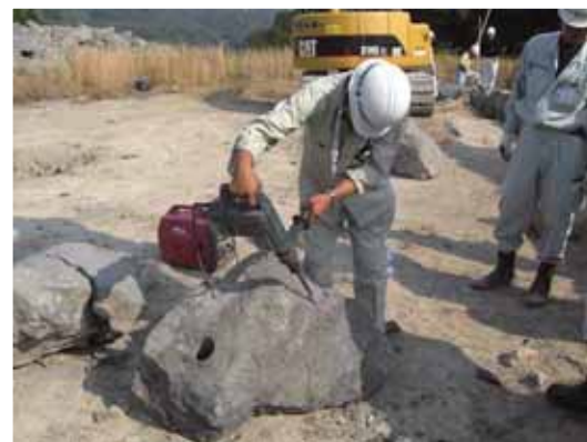
電動ピックによる石の加工
