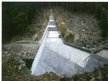
工事名: 火山砂防工事(牛尾川工区) 工事箇所: 伊佐市大口牛尾地区
