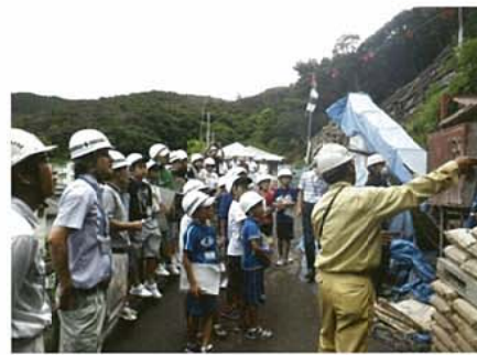
古仁屋13地区現場見学会【H24.7.5】
