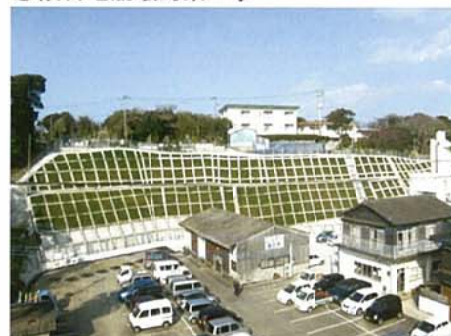
工事名: 総合流域防災(急傾斜)工事 (西町地区) 工事箇所: 西之表市西町地区
