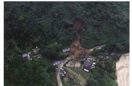
肝付町白木地内 がけ崩れ
