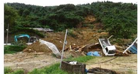
肝付町白木地内 がけ崩れ被害状況
