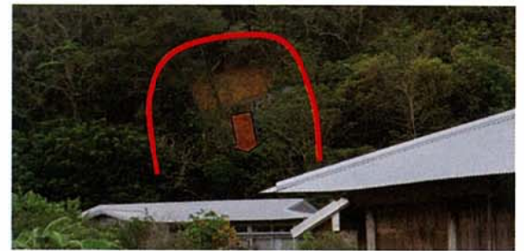
大島郡瀬戸内町三浦地区(がけ崩れ)
