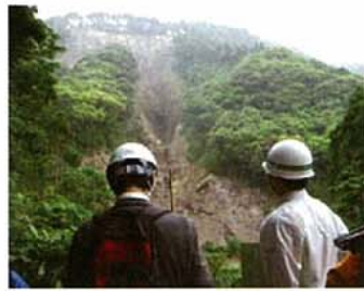
現地調査(根占山本地区)
