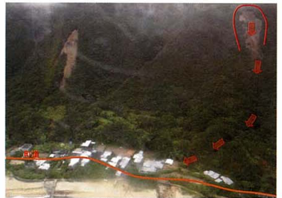
大島郡龍郷町加世間沢(土石流)
