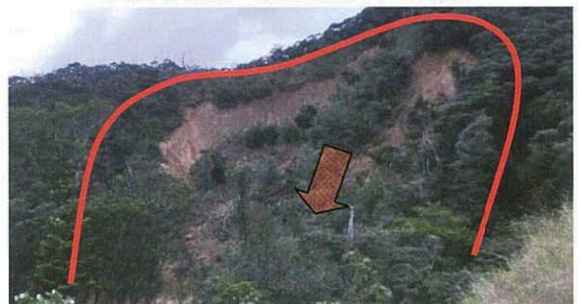
大島郡瀬戸内町西阿室地区(地すべり)
