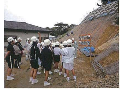
現場(急傾斜・山地区)見学会の様子
