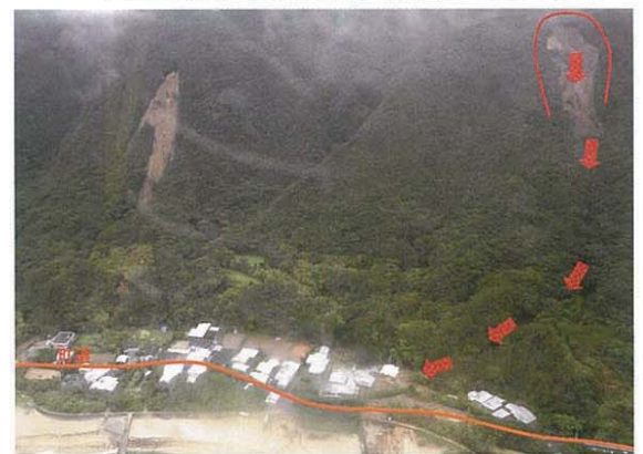
大島郡龍郷町加世間沢(土石流)
