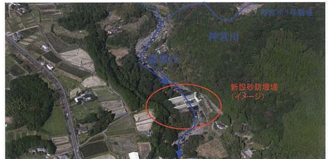
新設砂防堰堤位置の状況
