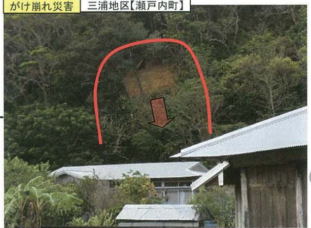
がけ崩れ災害 三浦地区【瀬戸内町】
