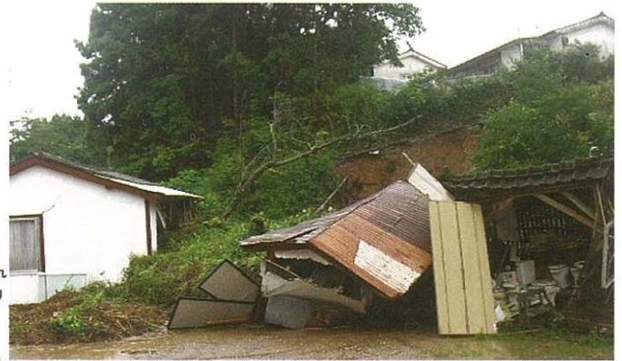
伊佐市南浦地区 がけ崩れ 全壊人家1戸、非住家1戸
