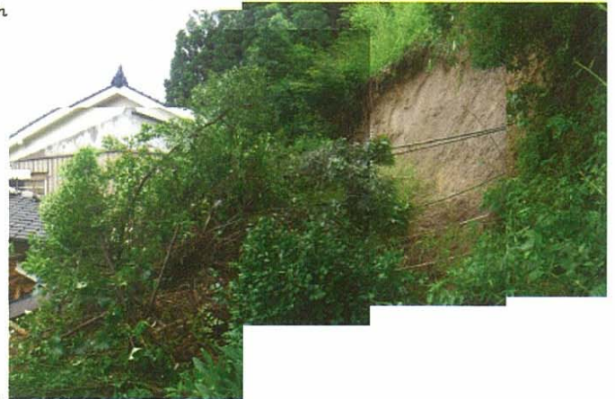
霧島市山ノ口地区 がけ崩れ 半壊人家1戸
